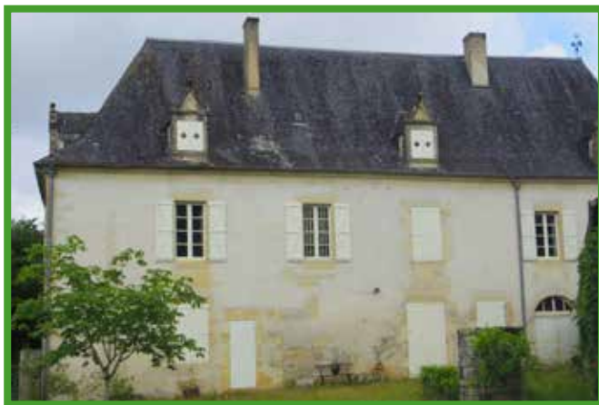
Façade est du château.
