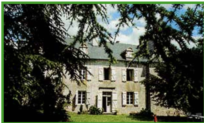
Façade ouest et jardin.
